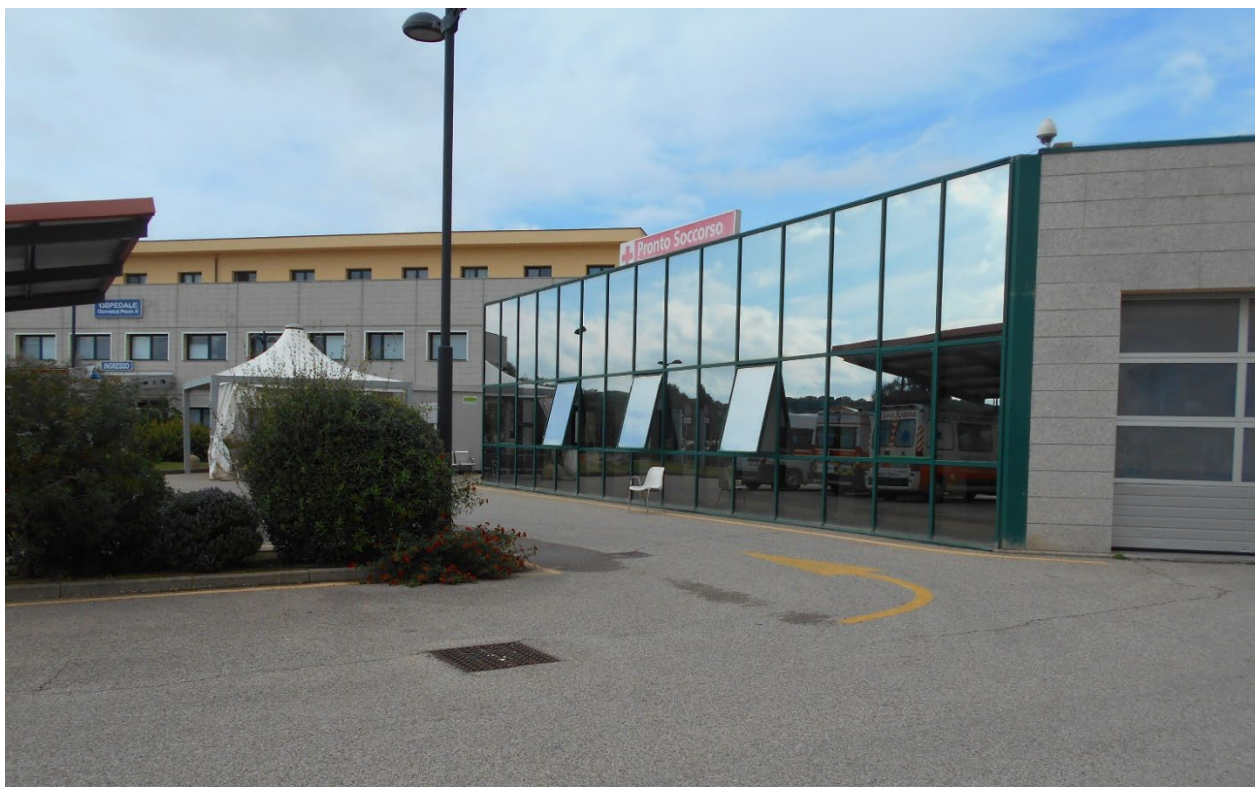
Figura 12 Viabilità di ingresso del Pronto soccorso
