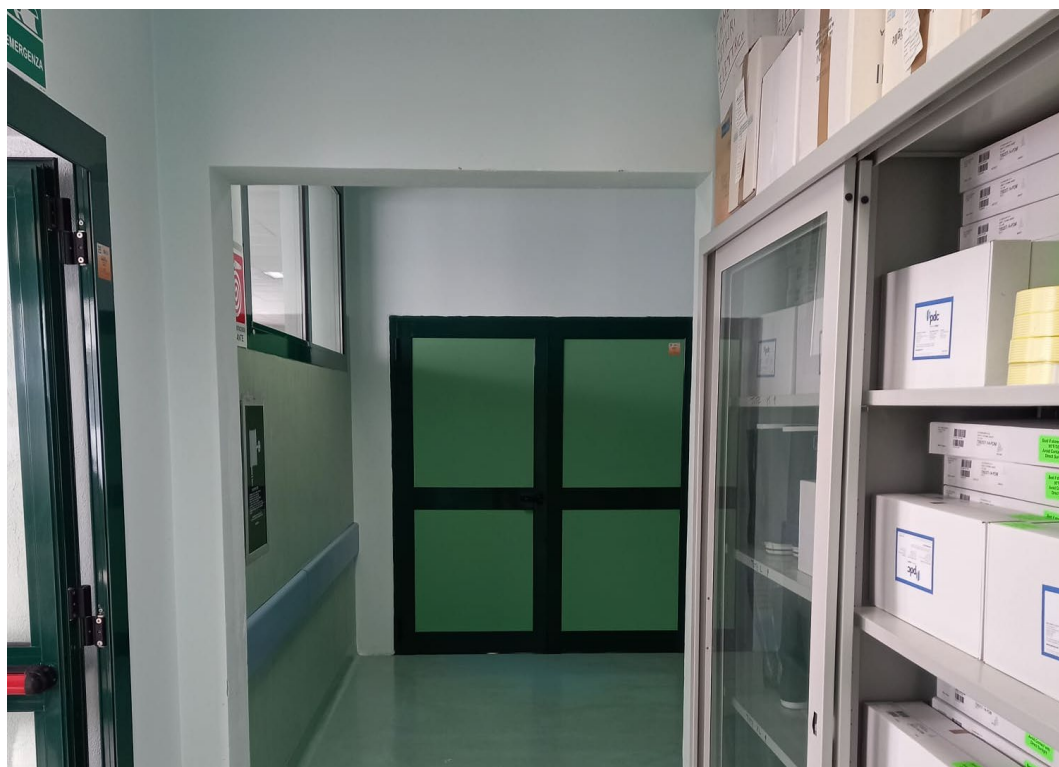
Figura 6 Corridoio di collegamento, Sala CCTV- Barellati
