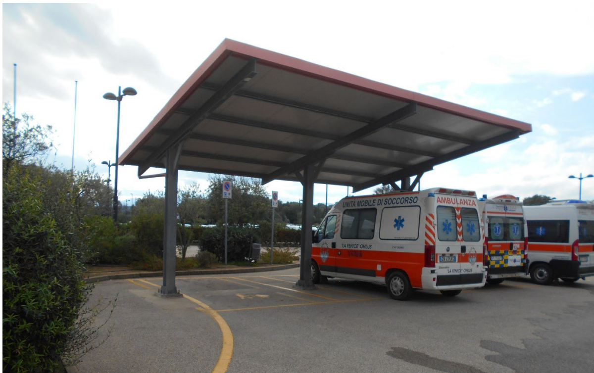
Figura 2 Fronte Pronto Soccorso- tettoia parcheggio Ambulanze
