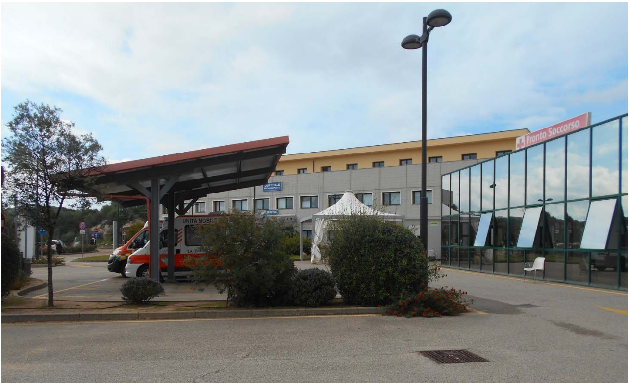
FOTO 2: interferenze individuate durante le fasi di rilievo.
