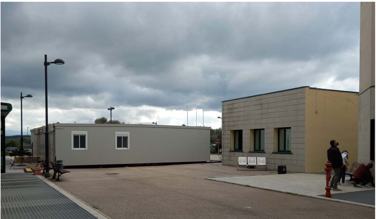
FOTO 3: interferenze individuate durante le fasi di rilievo.
